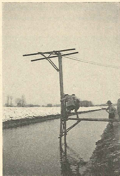
Unsere Pfadfinder beim Bau eines Steges über die Glatt.
